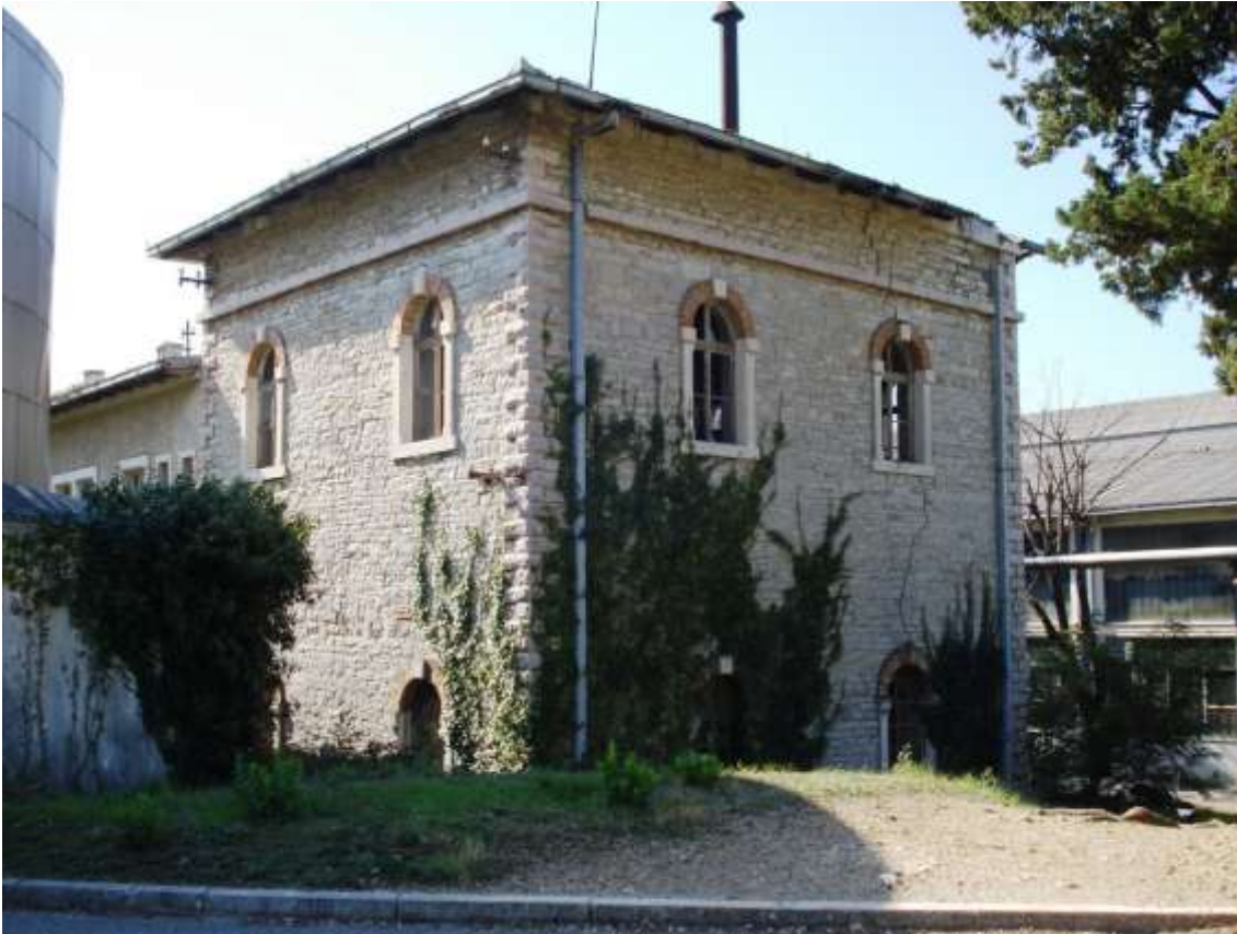
Slika 16: Vojno kupatilo – izgled objekta prije demontaže
