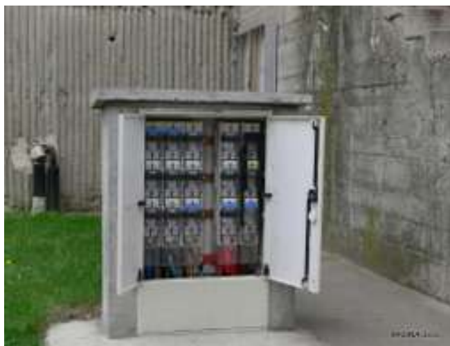
Slika. Izgled niskonaponskog razvodnog ormara sa 6 izvoda »NKRO6«
